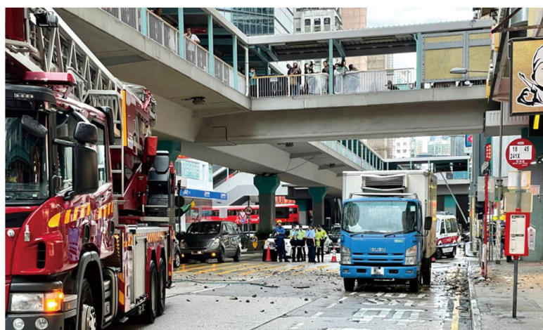
圖五：樓宇外牆石屎剝落事故
