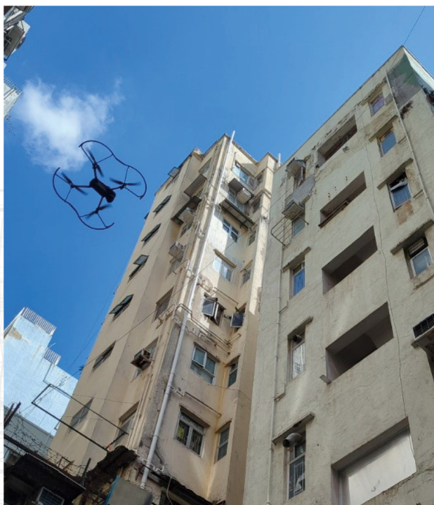
圖三：屋宇署用無人機進行樓宇外牆勘察
